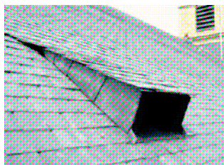
Chiroptière réalisée avec l'appui du Service technique provincial du Luxembourg à l'église de Nobressart (photo : J. Fairon)
