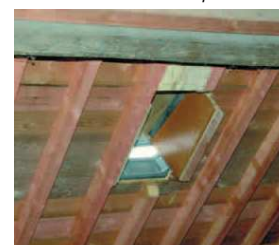
Aménagement d'une tabatière (photo : J. Fairon)
