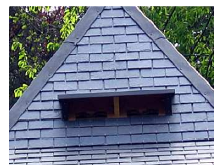
Chiroptière aménagée dans la toiture rénovée d'un pigeonnier, commune de Brassac, dans le Tarn (
